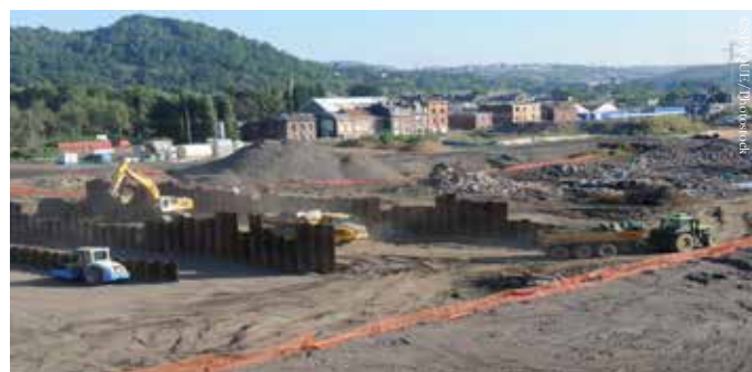
Cokerie Flemalle site
