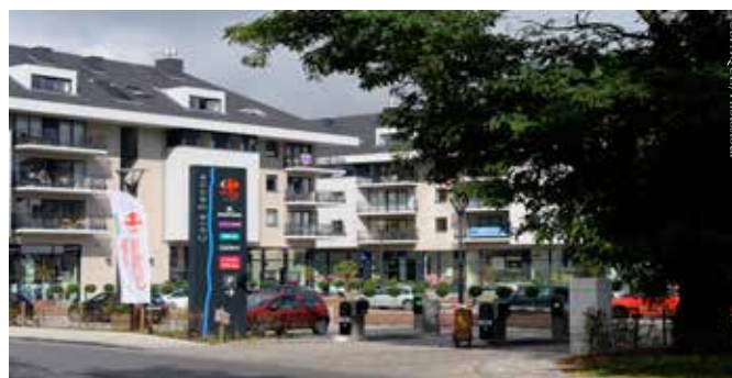
Tubize Côté Senne building complex
